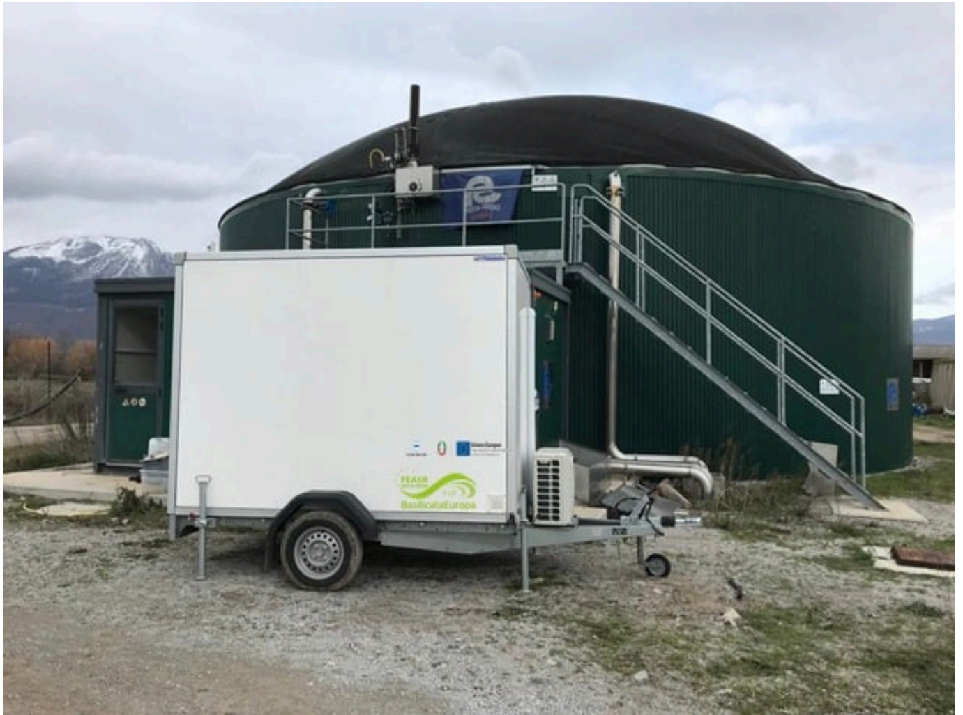
Figura 2. Unità mobile di bioconversione.
