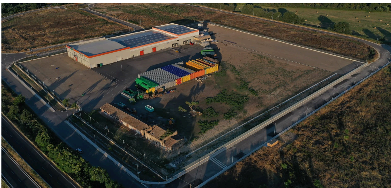
Figura 1. Foto aerea dello stabilimento Scanzano 2.
