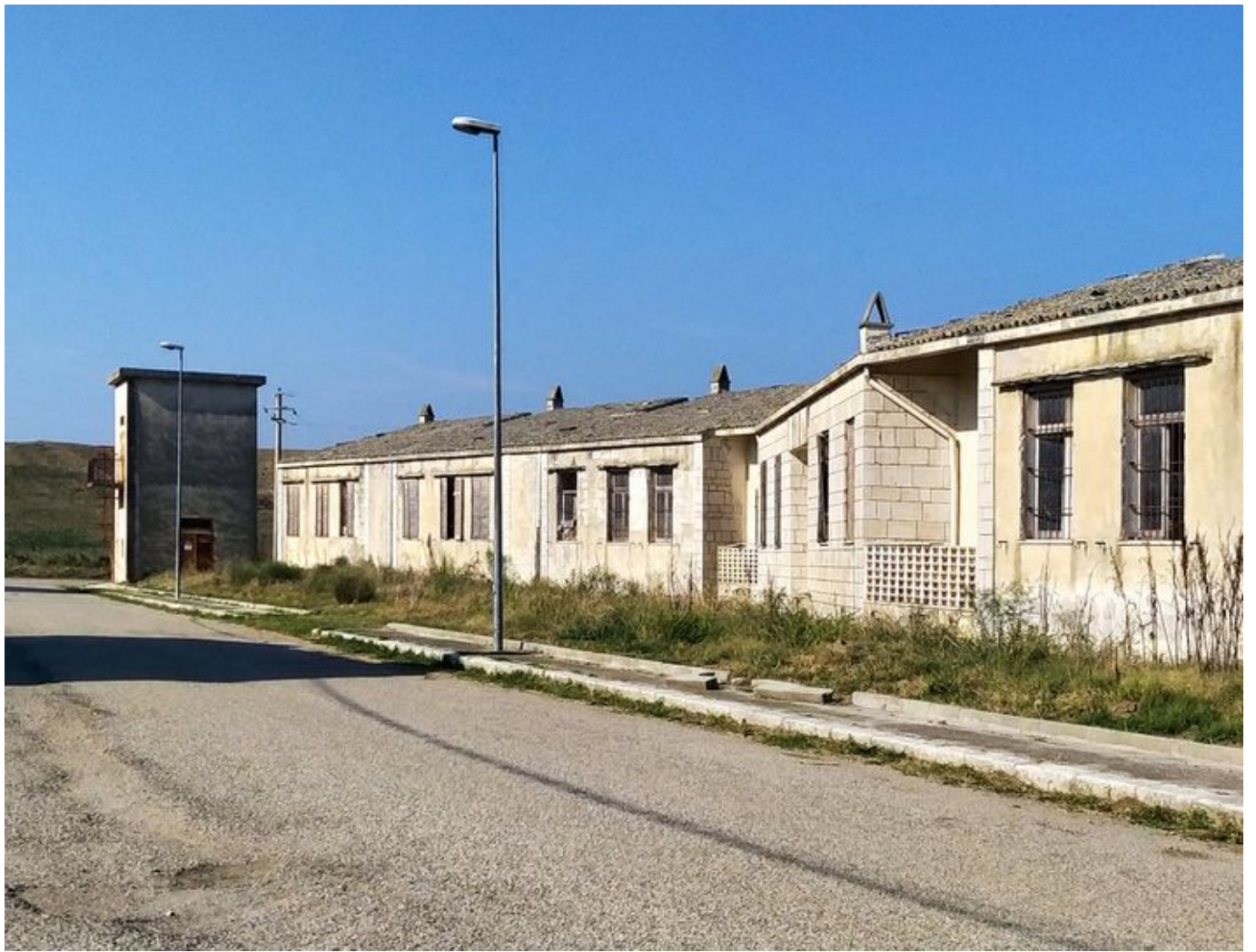
Figura 1. Borgo Taccone, Irsina (MT). Edificio scolastico.
