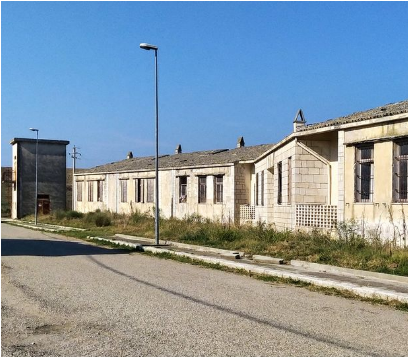
Figura 1. Borgo Taccone, Irsina (MT). Edificio scolastico
